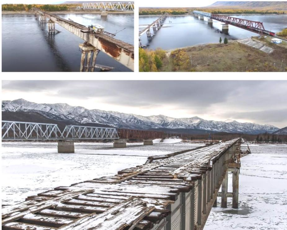
**Рис. 1. Железнодорожный мост на Байкало-Амурской магистрали через реку Витим на границе Республики Бурятия и Забайкальского края и разрушающийся автодорожный мост на автодублере**
