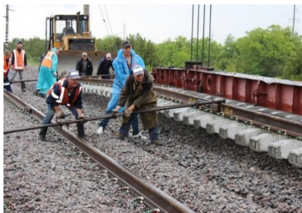
Рис. 2. Укладка пути с применением междупутного шаблона
