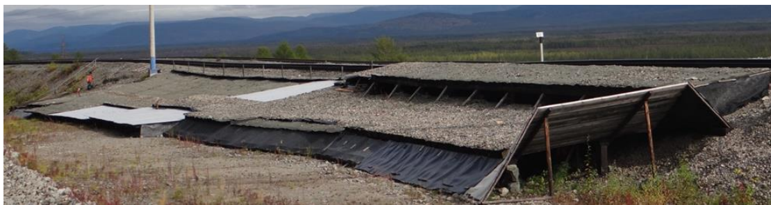
Рис. 14. Искусственное сооружение «СозН» 1687 км ПК10 – 1688 км ПК1, с запада от 11 сентября 2022 г Fig. 14. Artificial structure «SosN» 1687 km PK10 – 1688 km PK1, on the west from September 11, 2022
