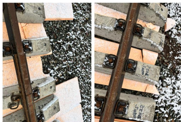
Рис. 1. Трещины на плитах из пенополистирола, появляющиеся во время их укладки
