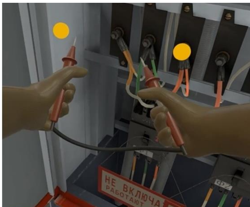
Рисунок 4 – Фотофрагмент процесса замены пускателя в РЩ – 0,4 кВ в режиме экзамена
