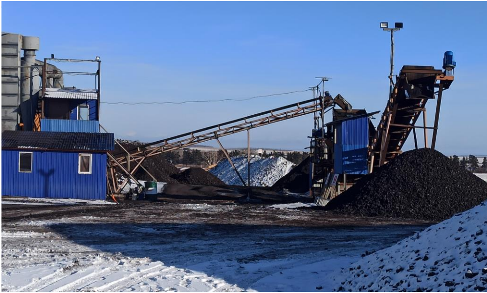
Рис. 3. Дробильная установка для подготовки угля к погрузке
