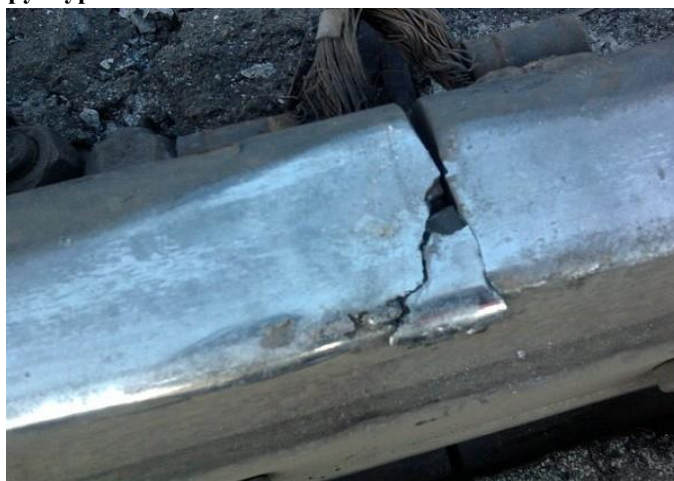
Рис.3 Выкрашивание металла на поверхности катания
