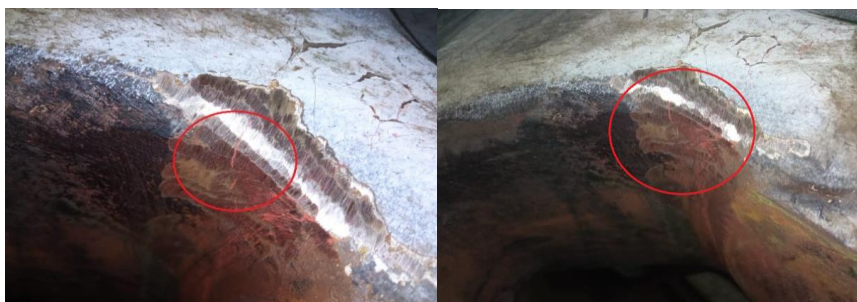
Рис.1. Трещина внутреннего радиуса буксового проема боковой рамы
