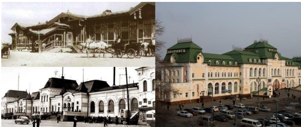
Рис. 1. Здание вокзала г. Хабаровск
