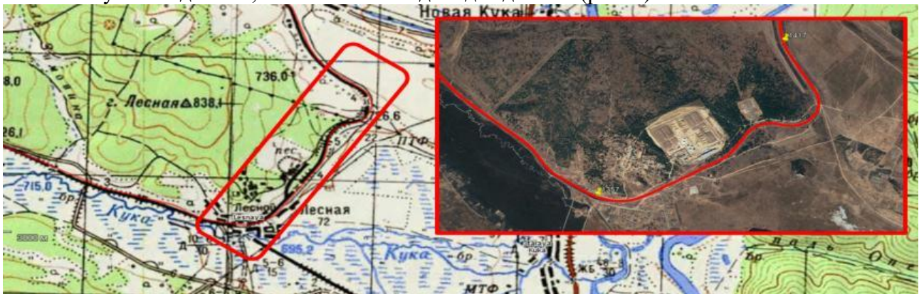
Рис. 7. Участок «проблемной зоны» на перегоне Лесная – Домна
