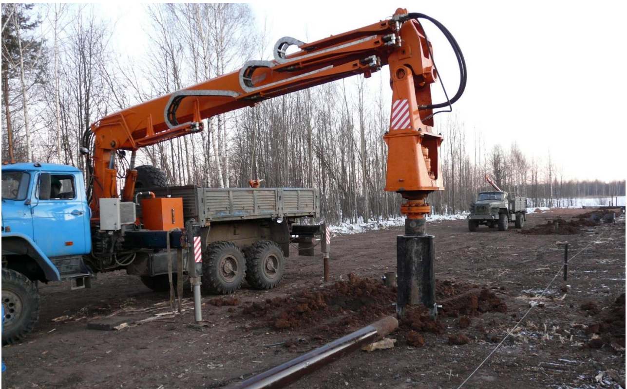
Рис. 2. Строительная техника на автомобильном ходу
