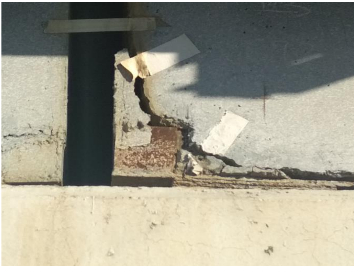
Рис.6 Опорная часть левой балки
