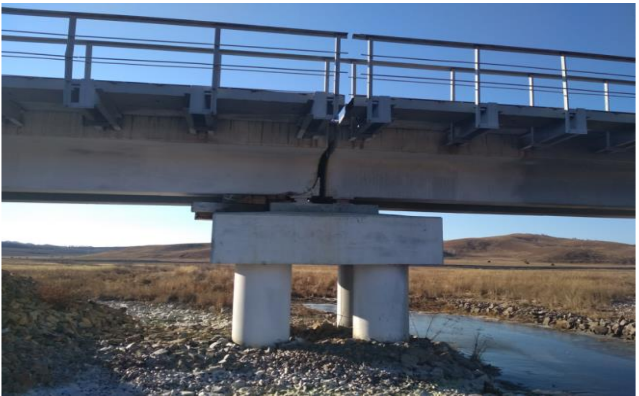
Рис.5 Правая балка пролетного строения
