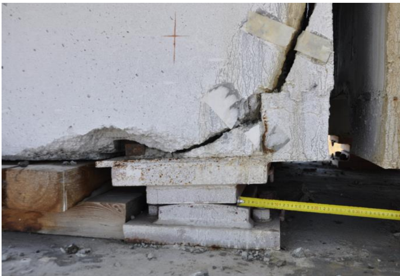
Рис. 7. Опорная часть правой балки
