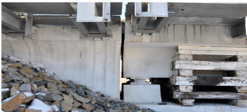
Рис. 9. Подферменник в середине опорной части левого устоя
