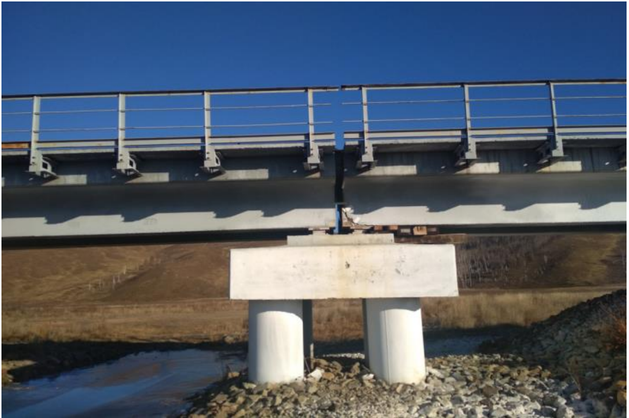
Рис.4 Левая балка пролетного строения
