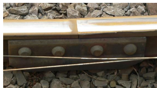
Рис. 12. Место перелета колеса при минимальном вертикальном уступе Fig. 12. The place of the wheel flight with a minimal vertical ledge
