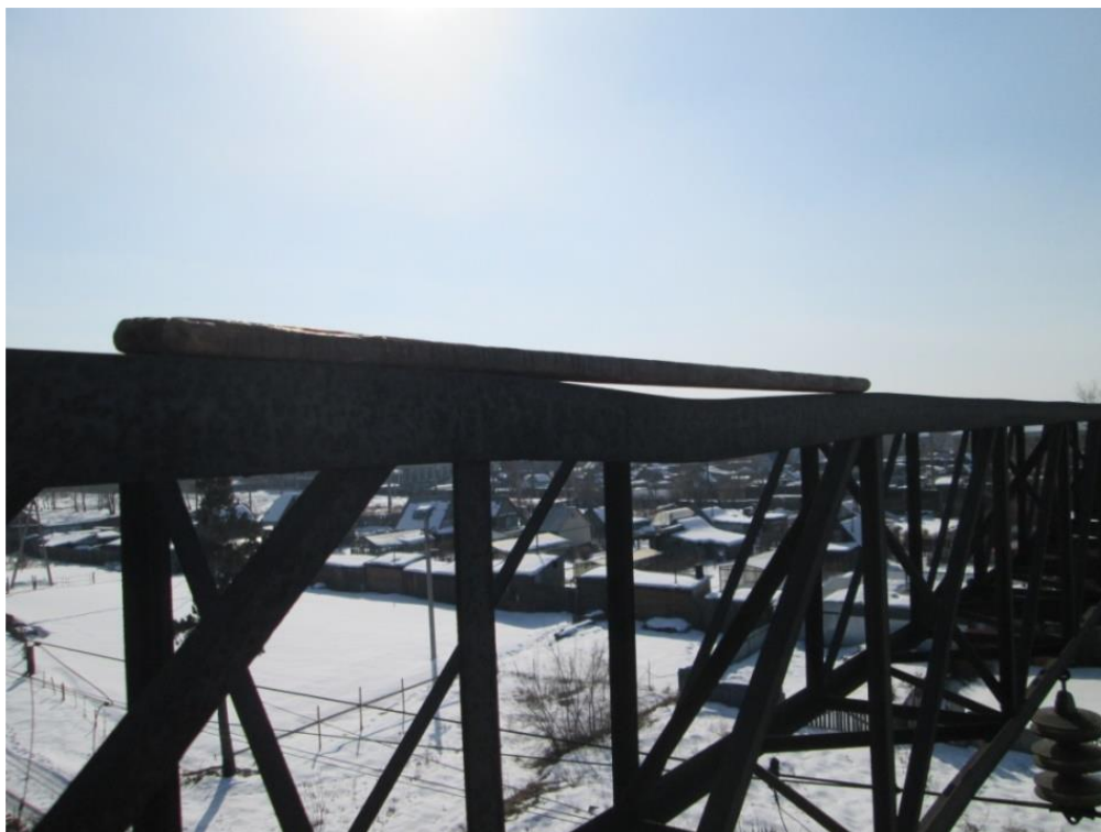
Рис. 1. Острodefектная жесткая поперечина по индексу 6.2М
