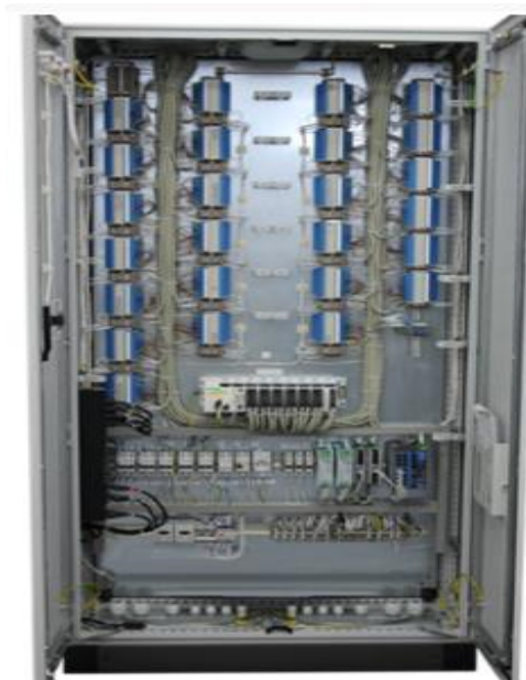
Рис. 4. Шкаф устройства сопряжения с объектом «Ш2800 03»
