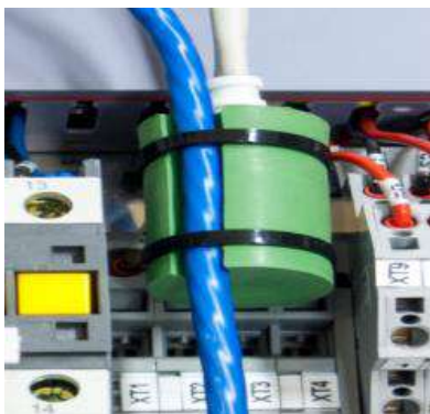
Рис. 5. Датчик тока Fig. 5. Current sensor
