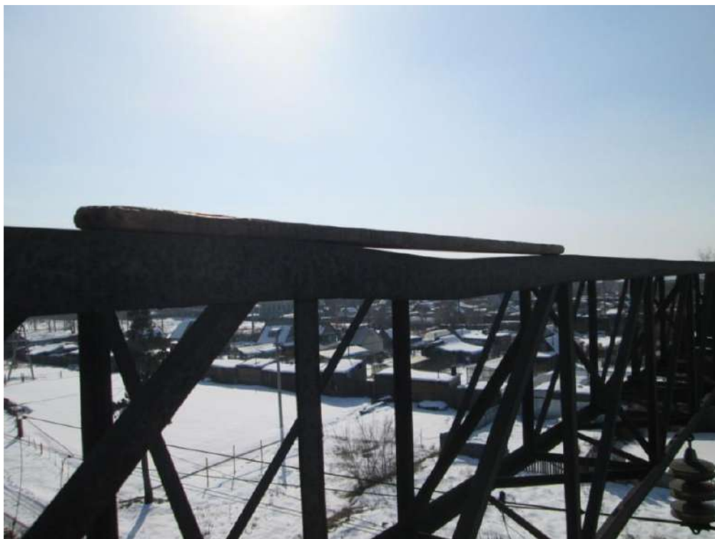
Рис. 1. Острodefектная жесткая поперечина по индексу 6.2М
