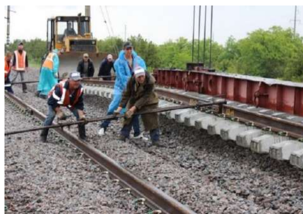
Рис. 2. Укладка пути с применением междупутного шаблона
