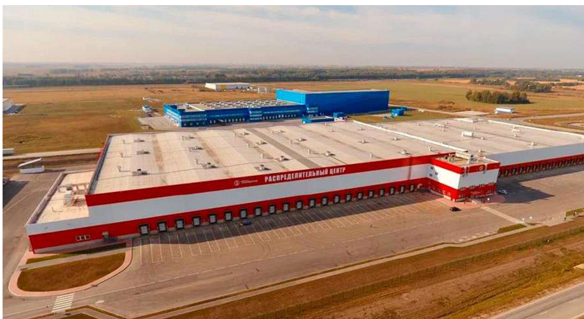
Рис. 2. Распределительный центр компании «П» в промышленно-логистическом парке Fig. 2. Distribution center of the company «P» in the industrial and logistics park
