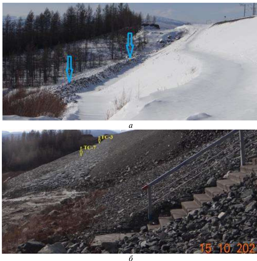
Рис. 12. 1686 км ПК8 – 1687 км ПК1 вид против хода километров: а – берма (март, 2021 г.); б – контрбанкет с бермой (октябрь, 2021 г.)
