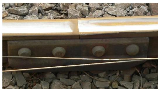
Рис. 12. Место перелета колеса при минимальном вертикальном уступе
