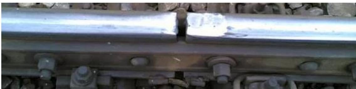
**Рис. 8.** Результат от горизонтального импульса в рельсовом стыке
