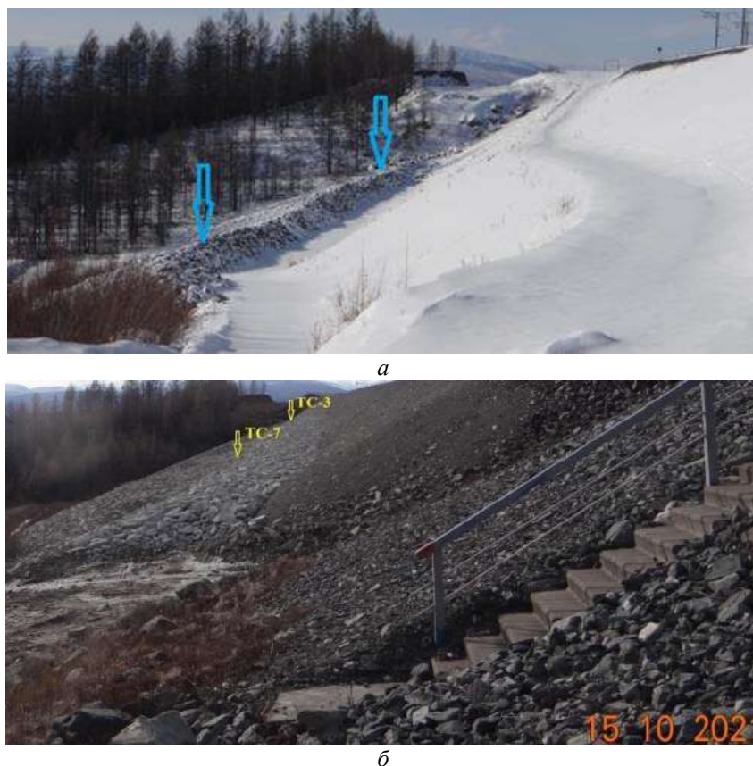
Рис. 12. 1686 км ПК8 – 1687 км ПК1 вид против хода километров: a – берма (март, 2021 г.); б – контрбанкет с бермой (октябрь, 2021 г.)
