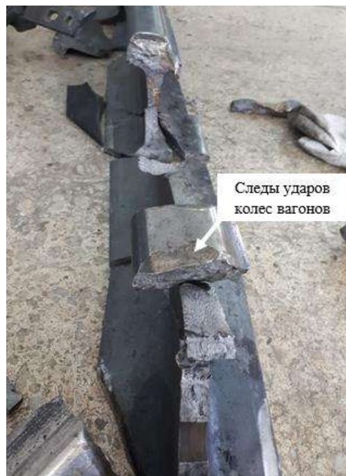
Рис. 1. Фрагменты разрушения рельса после схода (16 марта 2021 г.)
